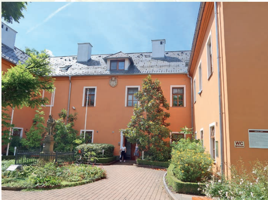
Budova zámku s barokní pískovcovou sochou Krista – Ecce Homo z roku 1758 (vlevo) a dvěma magnoliemi vedle vchodu
