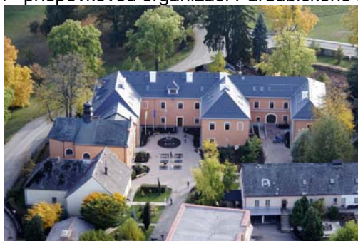
Zámecká budova po rekonstrukci, 2008
