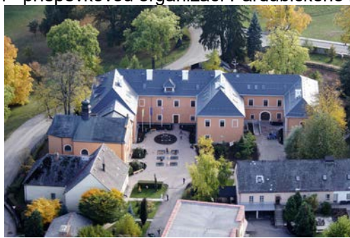
Zámecká budova po rekonstrukci, 2008
