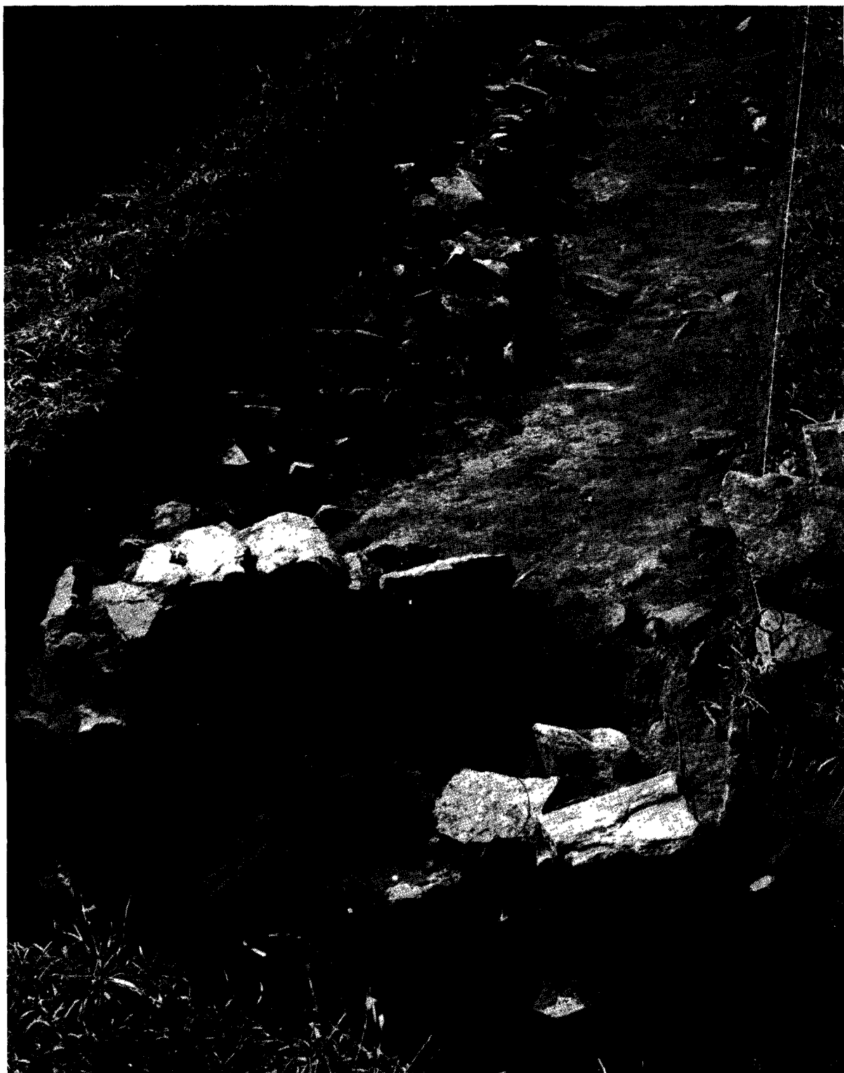
Obr. 25: Destrukce čelní zdi severního valu s kruhovým vyzděným objektem č. 19 v popředí.
