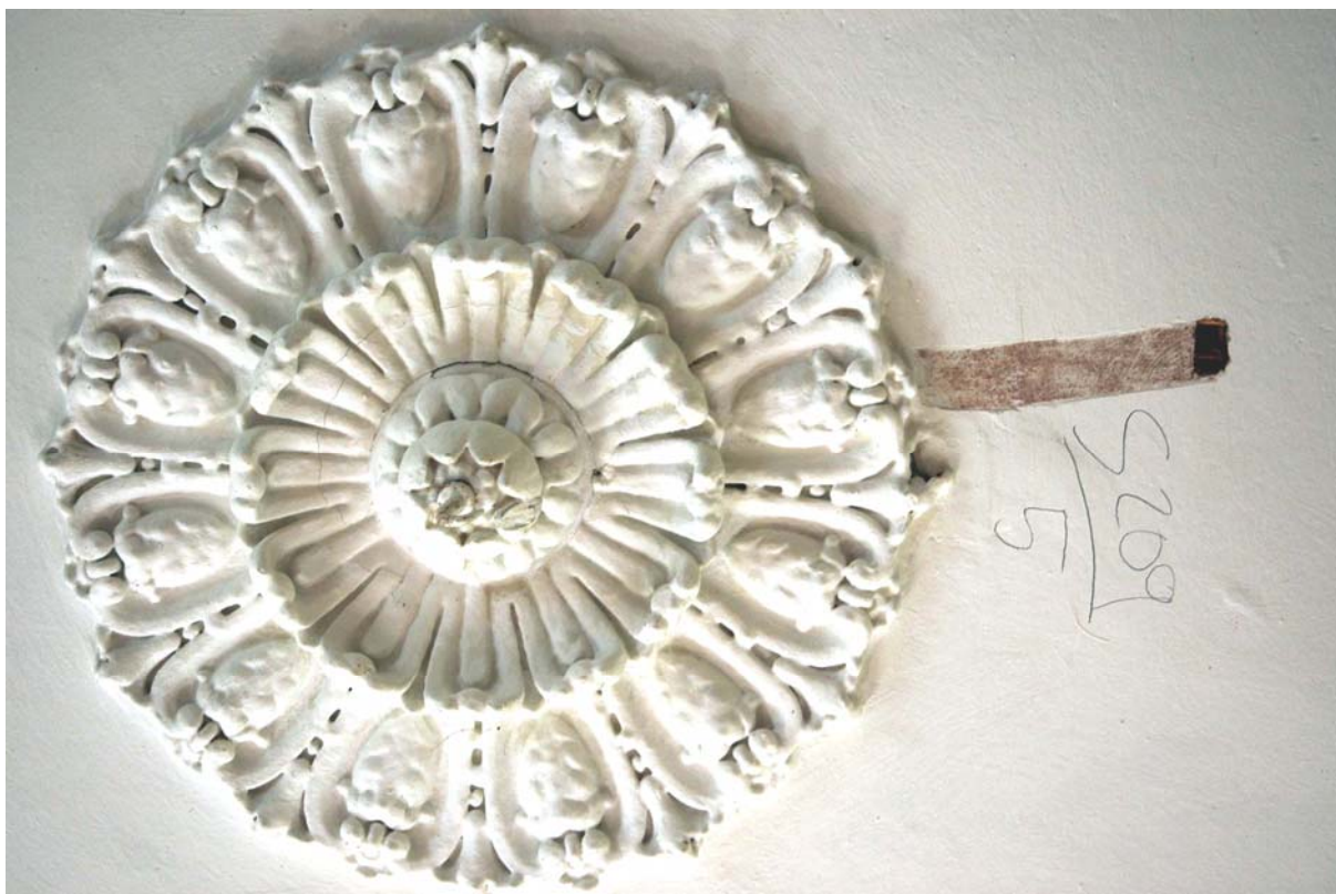
Stopy červené na rákosovém podbití stropu v místnosti S 209
