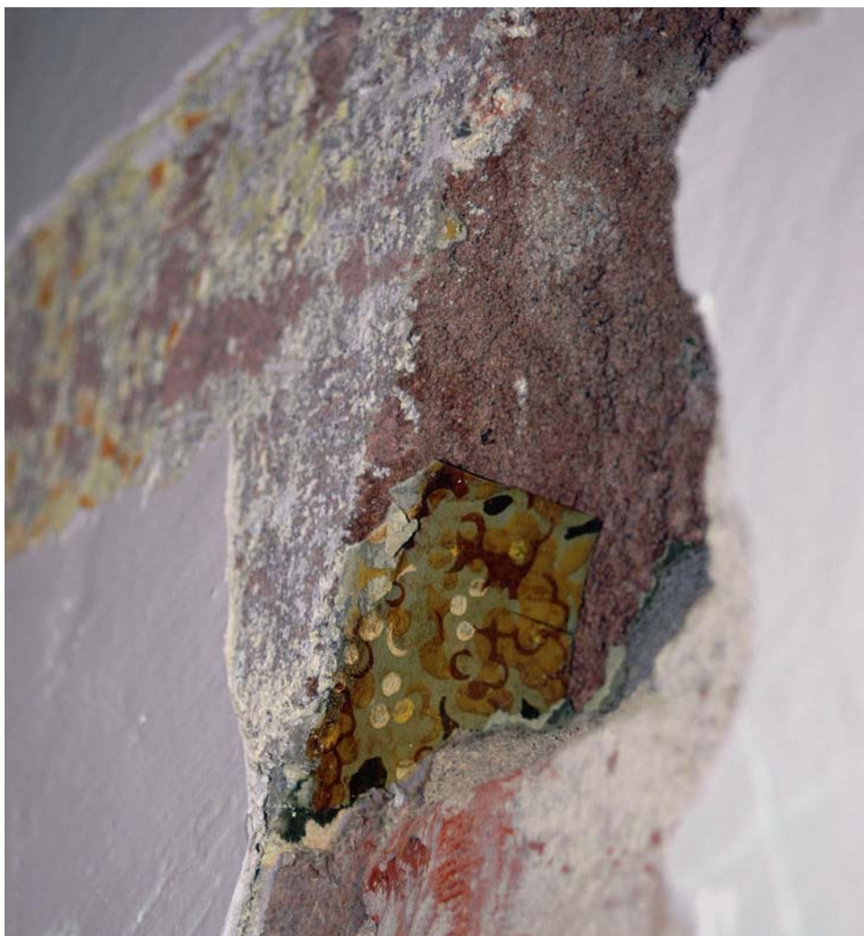
Detail zazděného průchodu (zbytky papírové mezivložky)
