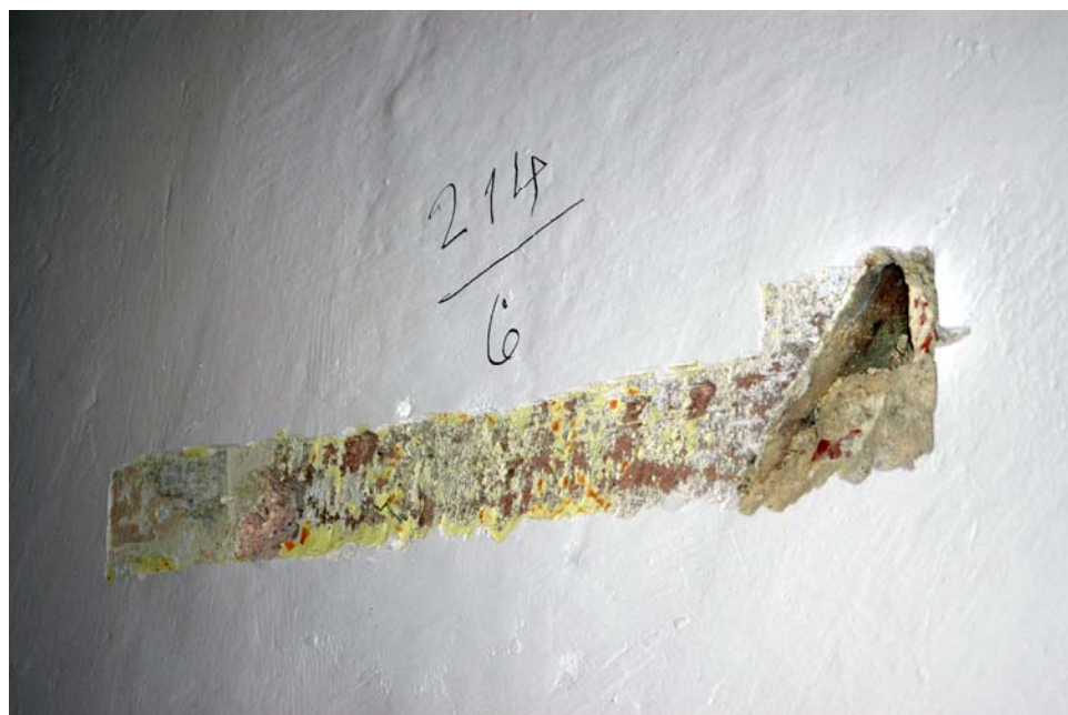
Postup odkrývání zazděného průchodu mezi místnostmi S 213 a S 214
