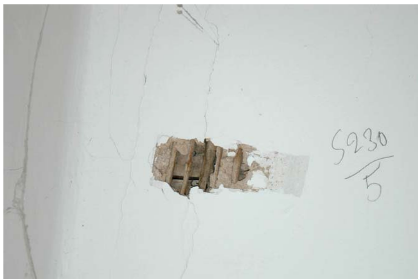
Rákosové podbití na stropě
