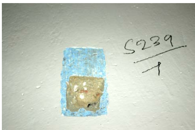
Pod novodobými nátěry vápenná omítka s kusy vápna
