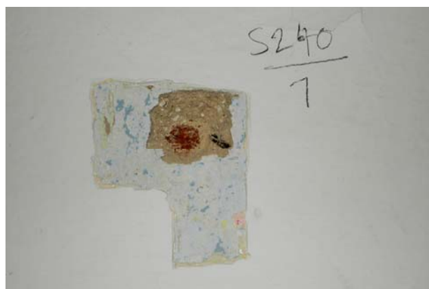
Pod novodobými nátěry vápenná omítka s kusy vápna
