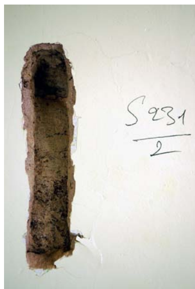
Tvrdá cementová omítka na kameni
