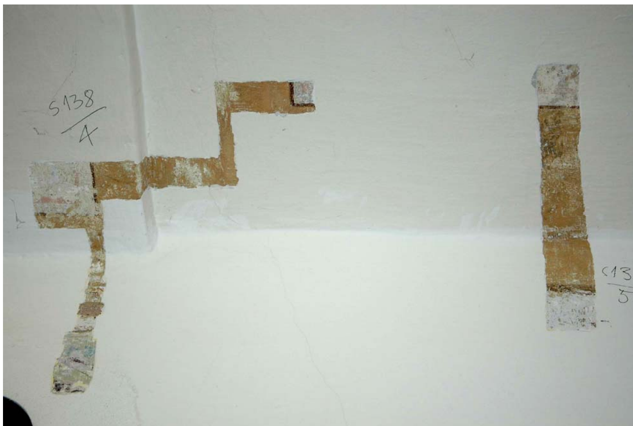
Barevná výzdoba v místnosti 138 (celkový pohled na sondy S 138/4 a 5)
