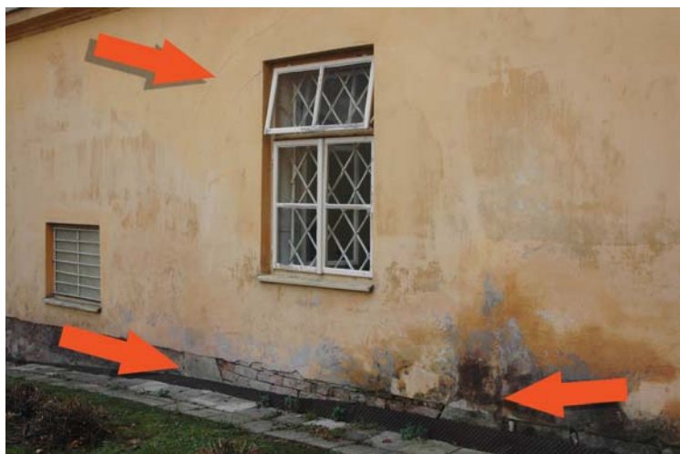
Zazděný portál, okno do místnosti č.137
