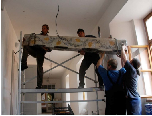
Umístění trámu na určené místo
