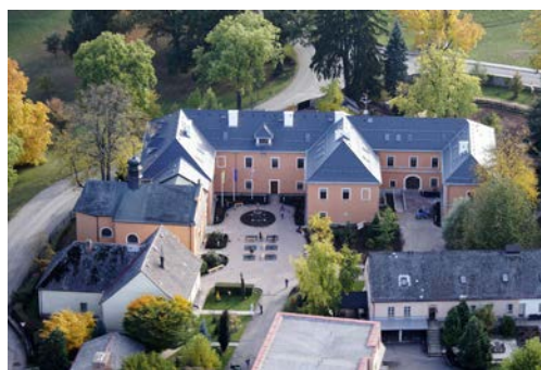
Zámecká budova po rekonstrukci
