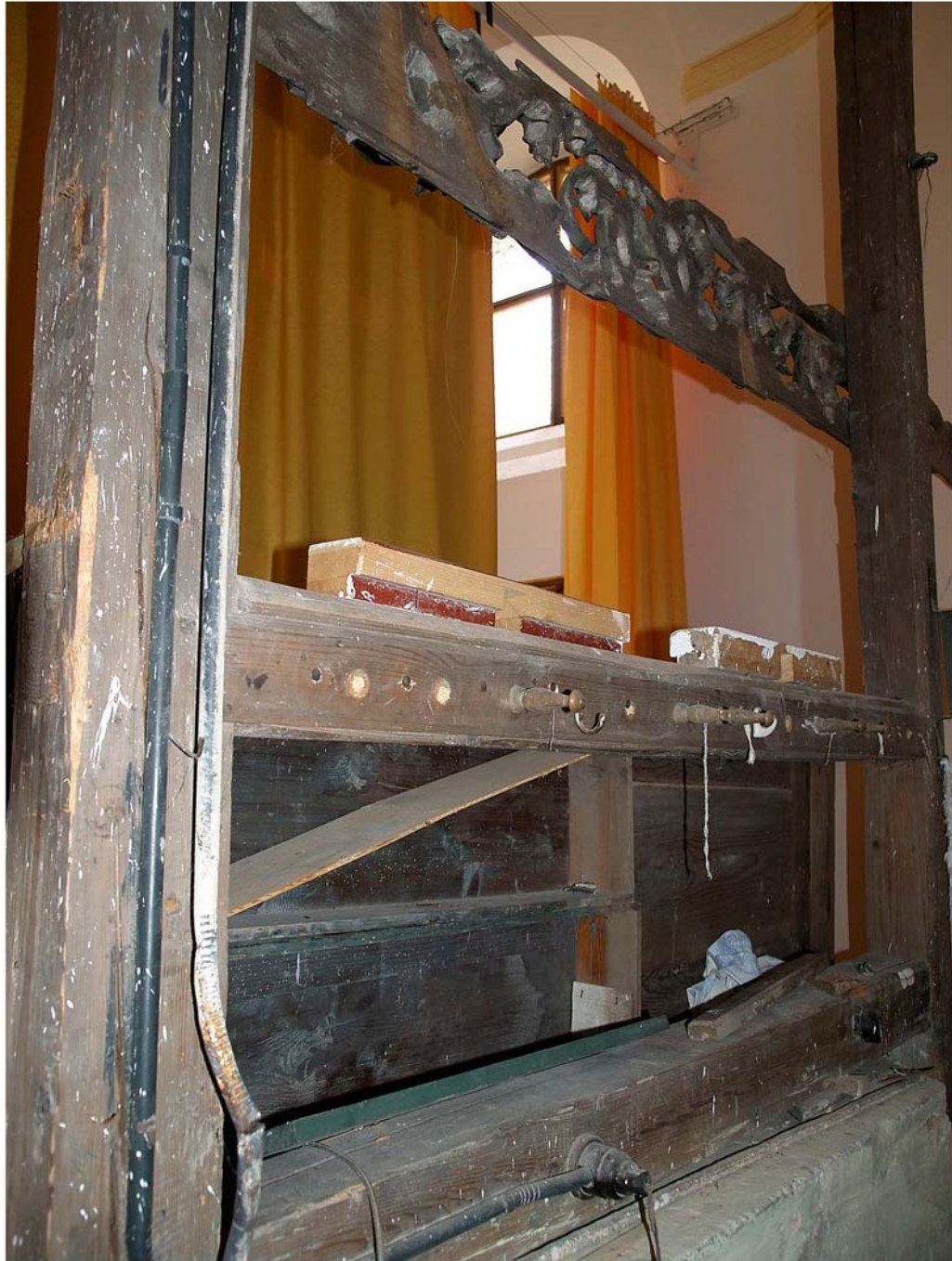
Zadni strana oltare tramova konstrukce s provizome zavesenou rezbou
