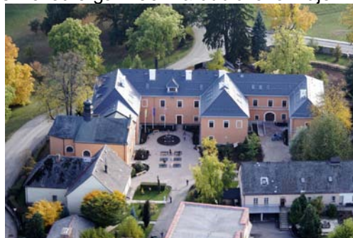
Zámecká budova po rekonstrukci
