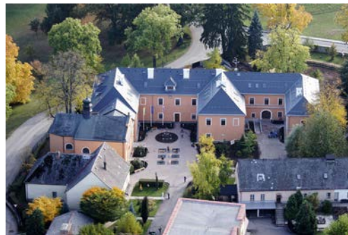
Záměcká budova po rekonstrukci, 2008
