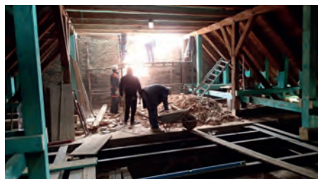
Rekonstrukce v půdních prostorách objektu.
