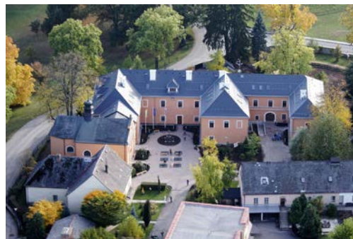
Zámecká budova po rekonstrukci, 2008
