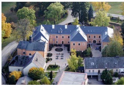
Záměcká budova po rekonstrukci, 2008
