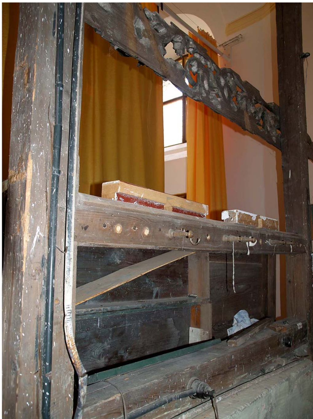
Zadní strana oltáře trámová konstrukce s provizorně zavěšenou řezbou
