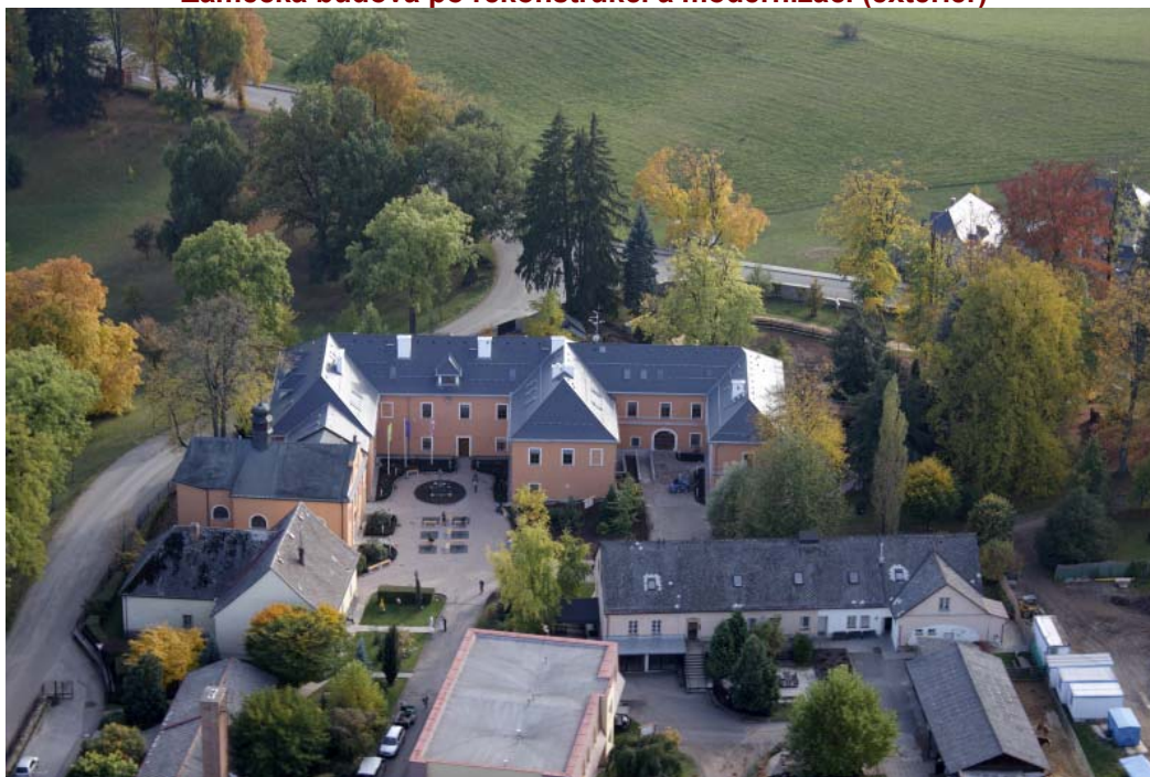
Zámecká budova po rekonstrukci a modernizaci (exteriér)
