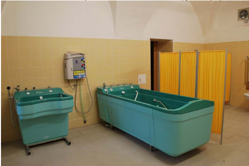
Zámecká budova po rekonstrukci a modernizaci (fyzioterapie)
