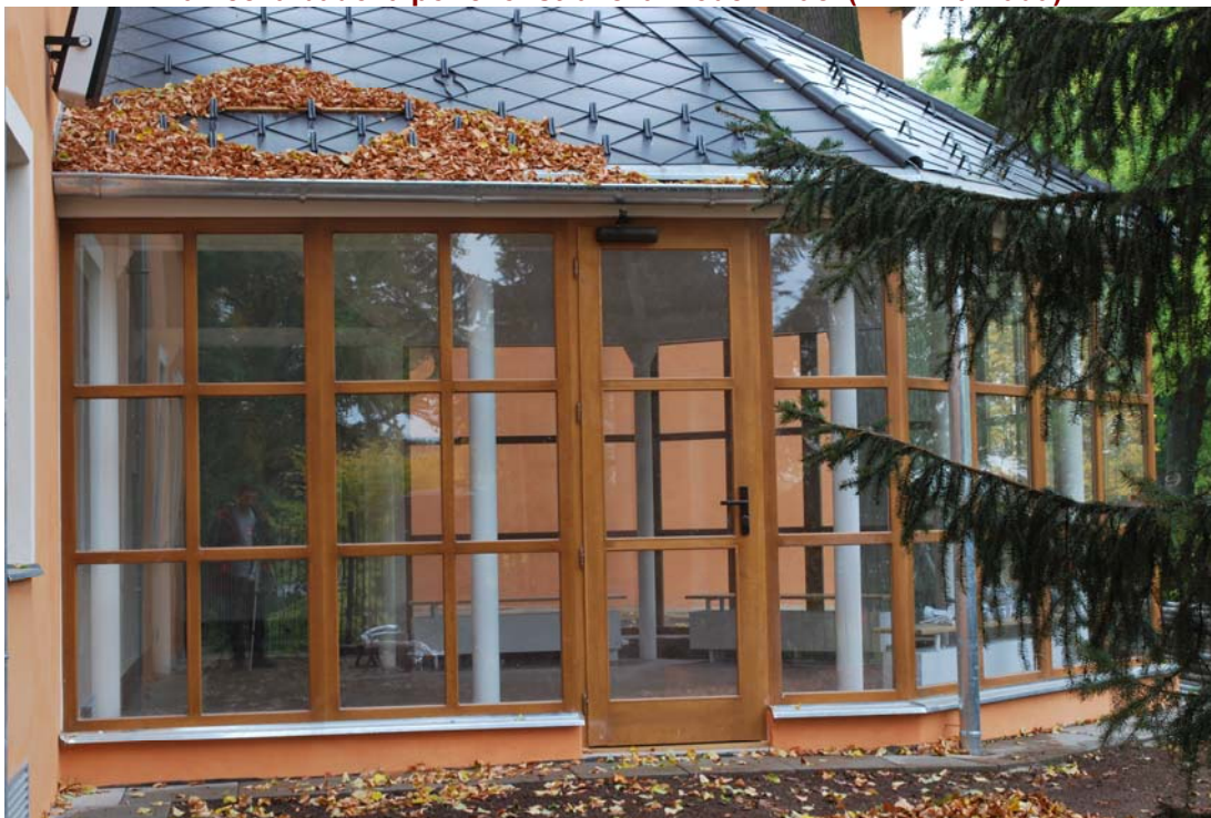
Zámecká budova po rekonstrukci a modernizaci (zimní zahrada)
