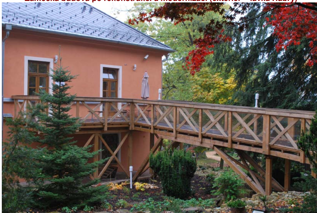
Zámecká budova po rekonstrukci a modernizaci (exteriér – lávka Habry)
