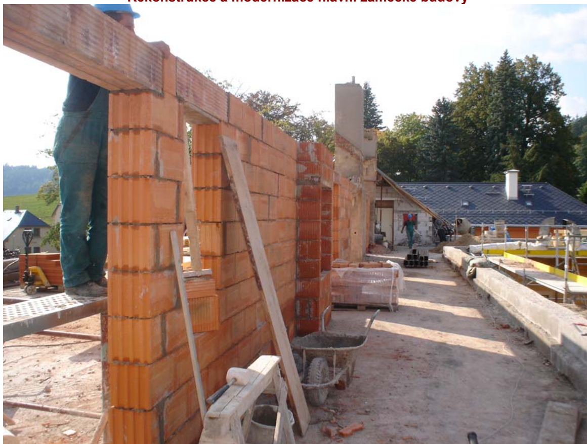
Rekonstrukce a modernizace hlavní zámecké budovy
