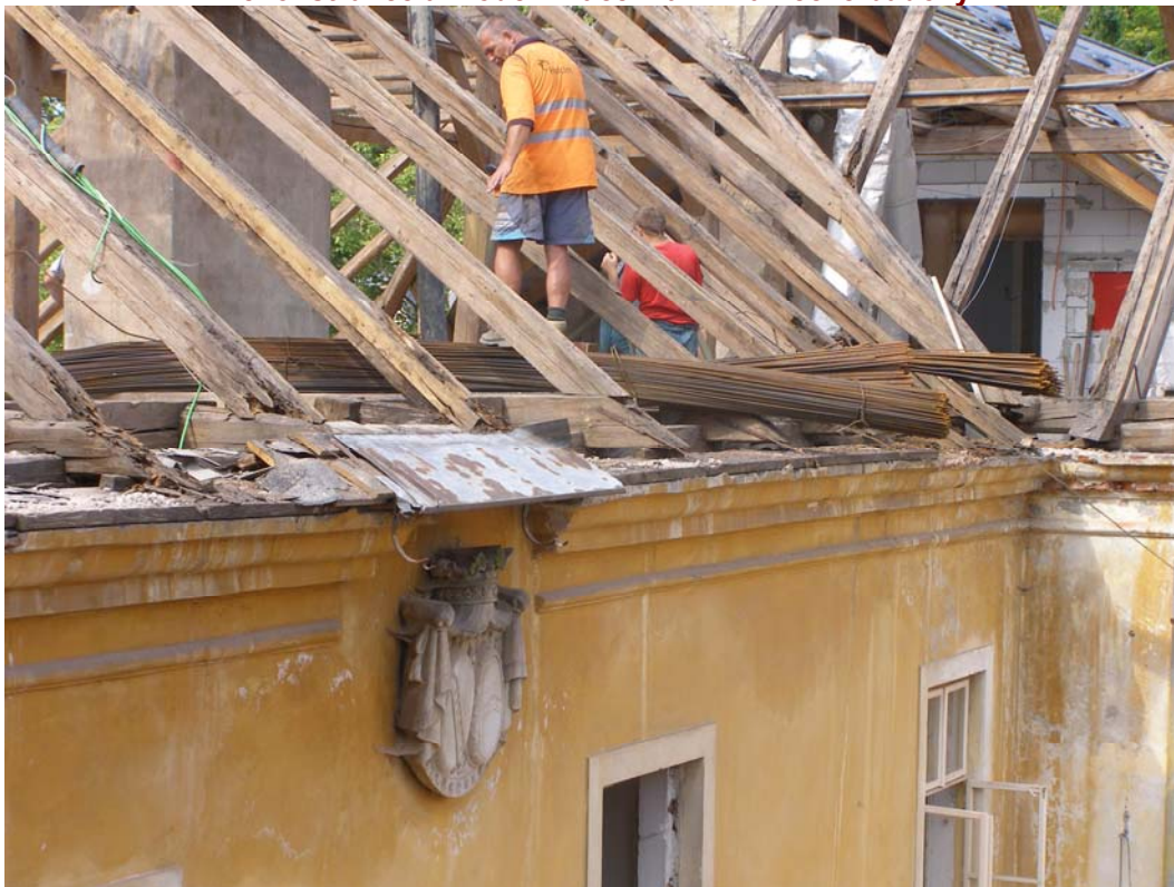
Rekonstrukce a modernizace hlavní zámecké budovy
