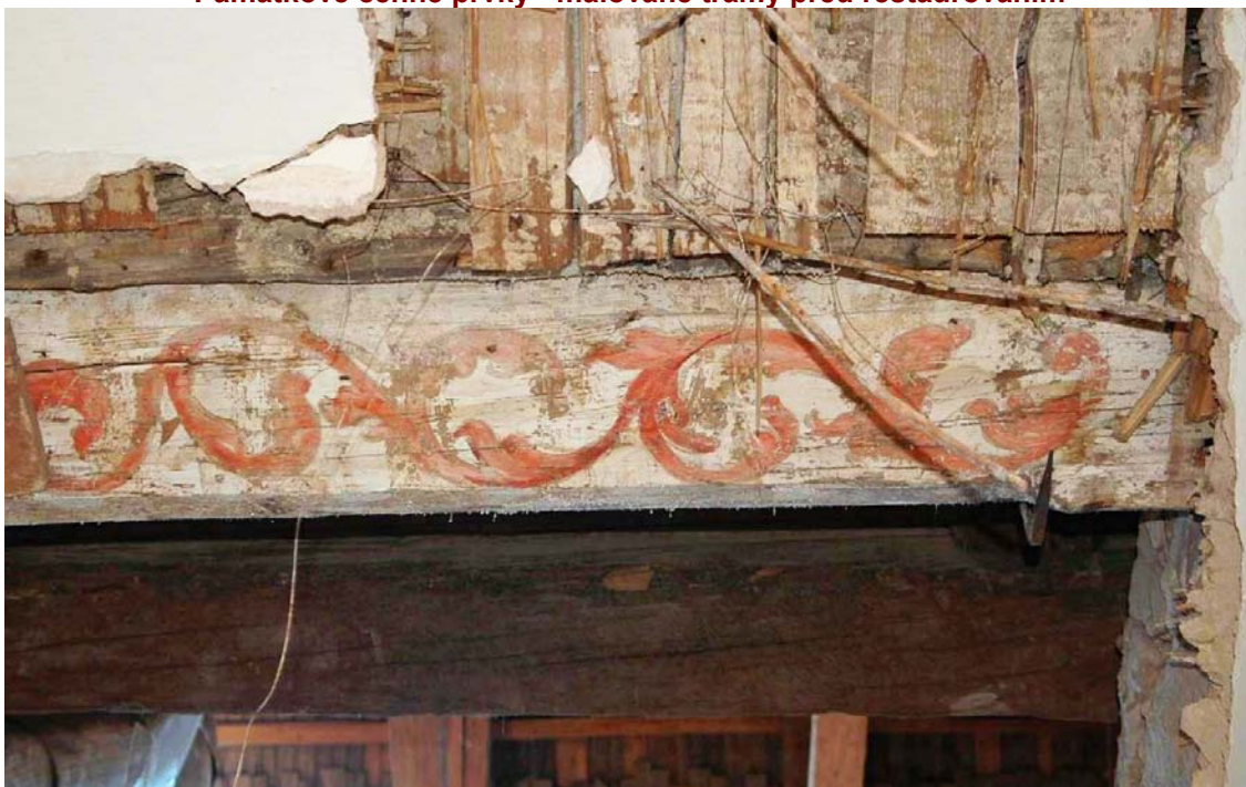
Památkově cenné prvky - malované trámy před restaurováním
