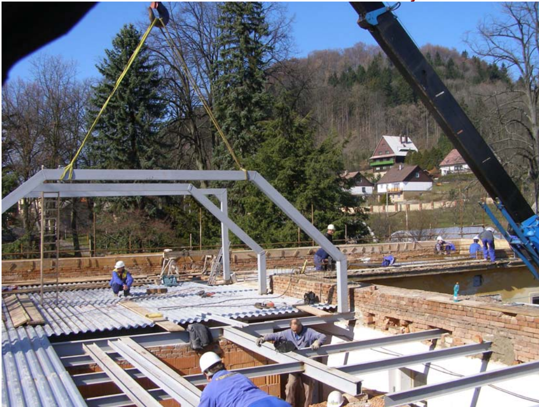
Rekonstrukce a modernizace hlavní zámekové budovy v r.2007
