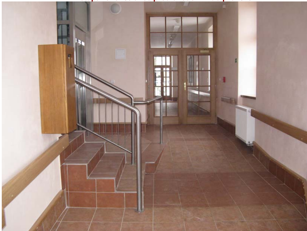
První etapa rekonstrukce před uvedením do provozu
