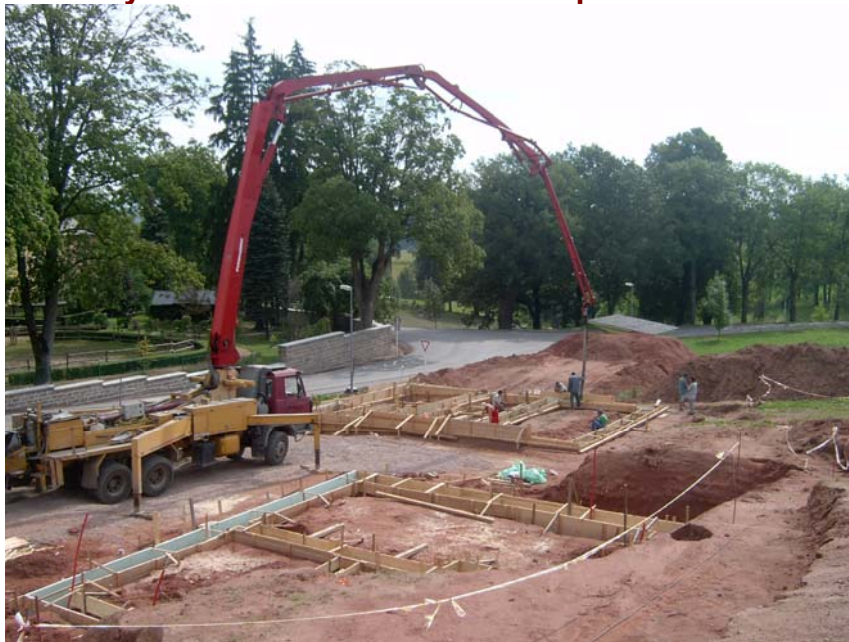
Výstavba Domků ve stráni Žampach r. 2004
