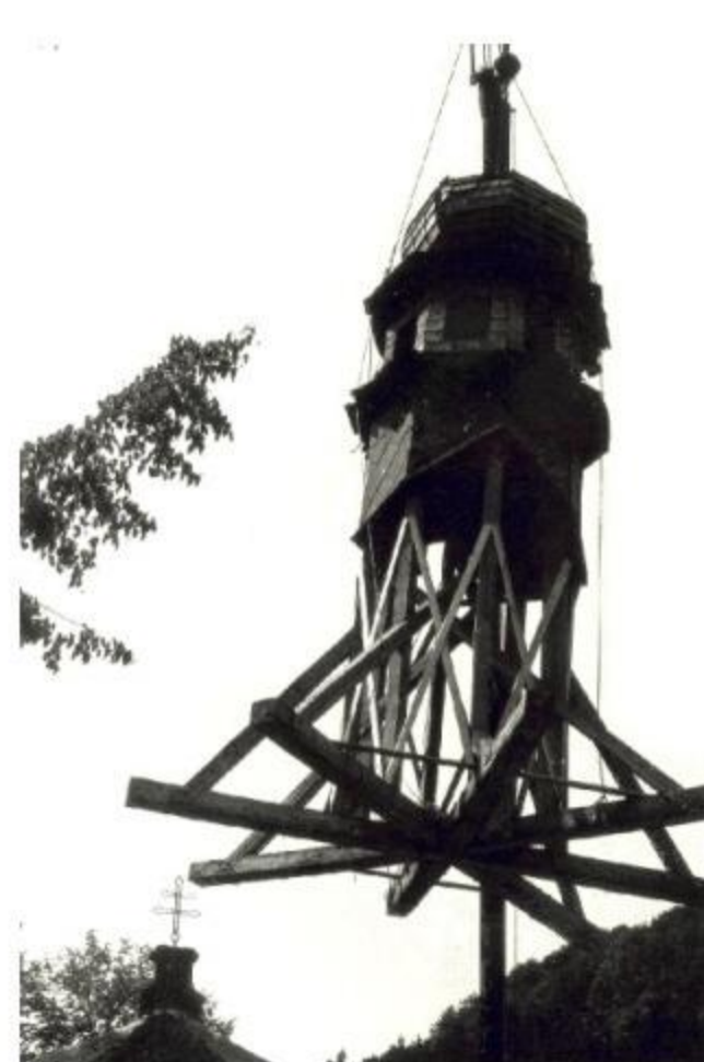
Demontáž věže kaple
