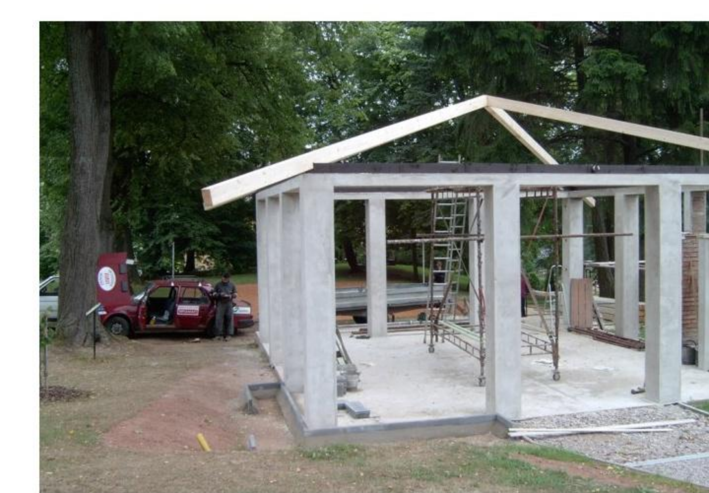
Zahradní altán - výstavba
